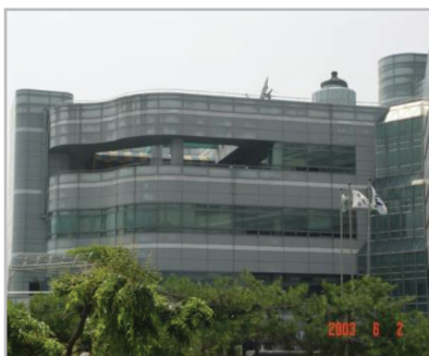
도장 불량으로 인해 얼룩진 불소도료 적용 패널 : 내마모성이 떨어짐 (실버 메탈릭 색상)
