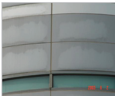
도장 불량으로 인해 얼룩진 불소도료 적용 패널 : 내마모성이 떨어짐 (실버 메탈릭 색상)
