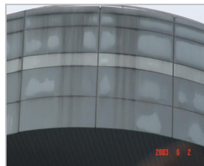
도장 불량으로 인해 얼룩진 불소도료 적용 패널 : 내마모성이 떨어짐 (실버 메탈릭 색상)
